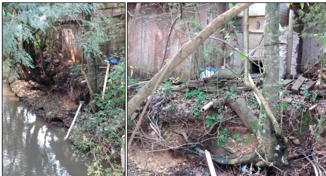
Figura 69 – Lançamento de esgoto bruto no Arroio Porongo – próximo ao Posto de Saúde
