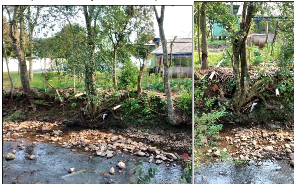
Figura 70 – Lançamento de esgoto bruto no Arroio Porongo
