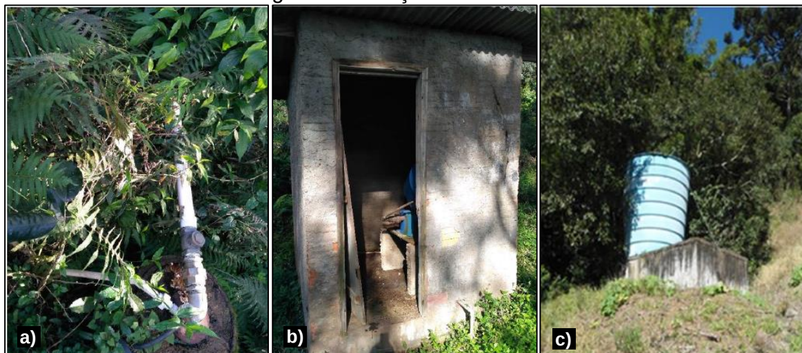
Figura 46 – Poço Moinho Zanetti
