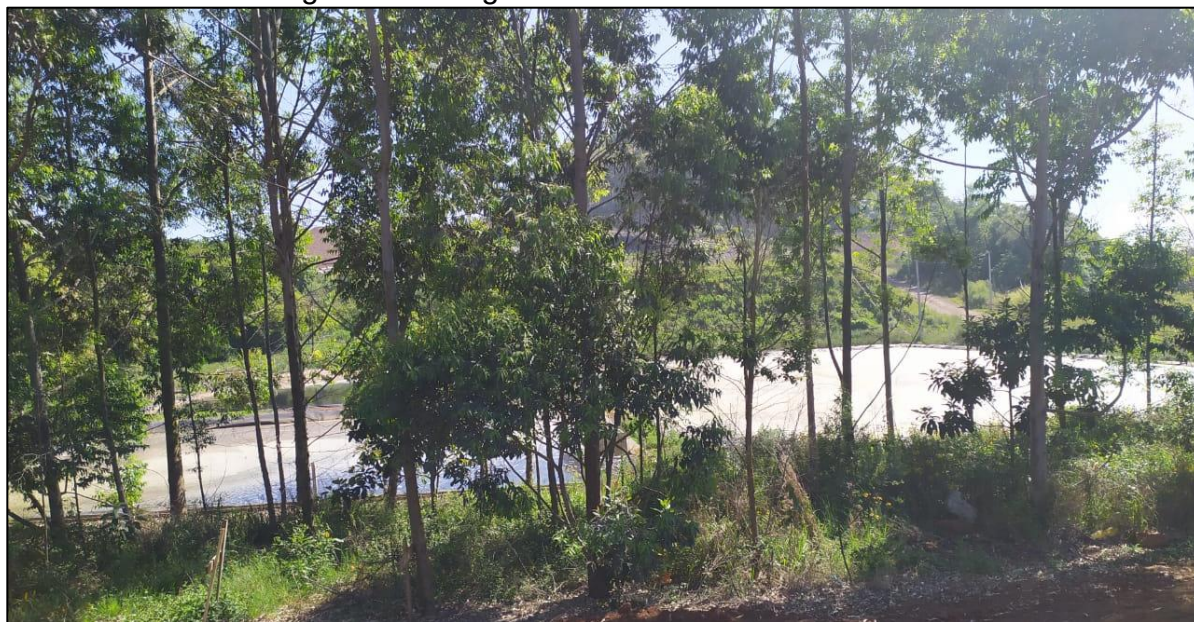
Figura 17 – Lagoas de tratamento do chorume
