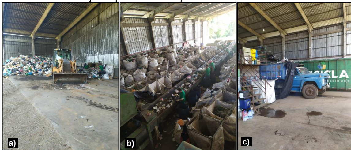
Figura 19 – a) Descarregamento dos resíduos b) Esteira e triagem c) Despejamento dos rejeitos para serem dispostos no aterro sanitário.
