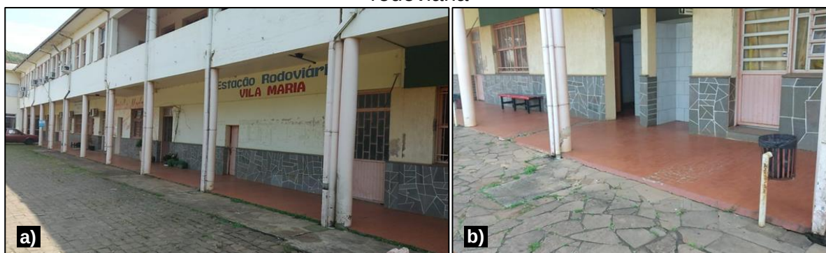
Figura 25 – a) Estação Rodoviária de Vila Maria b) Vista externa dos banheiros da rodoviária
