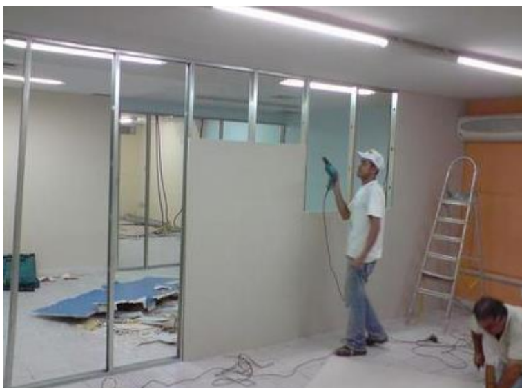
Fig.04: Ilustração das divisórias em drywall.
