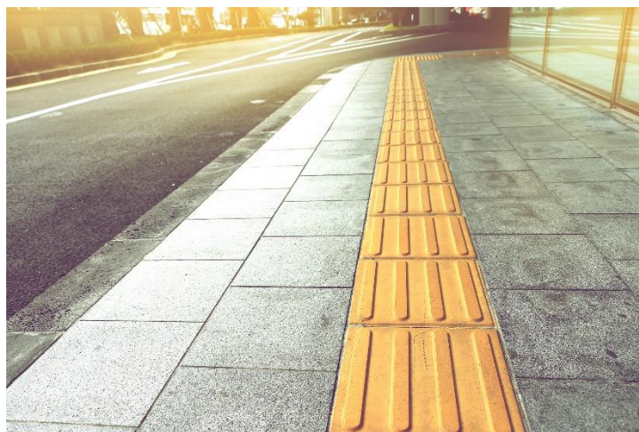
Figura 2. Piso tátil de concreto, dimensões de 40x40cm, E=2,5cm
