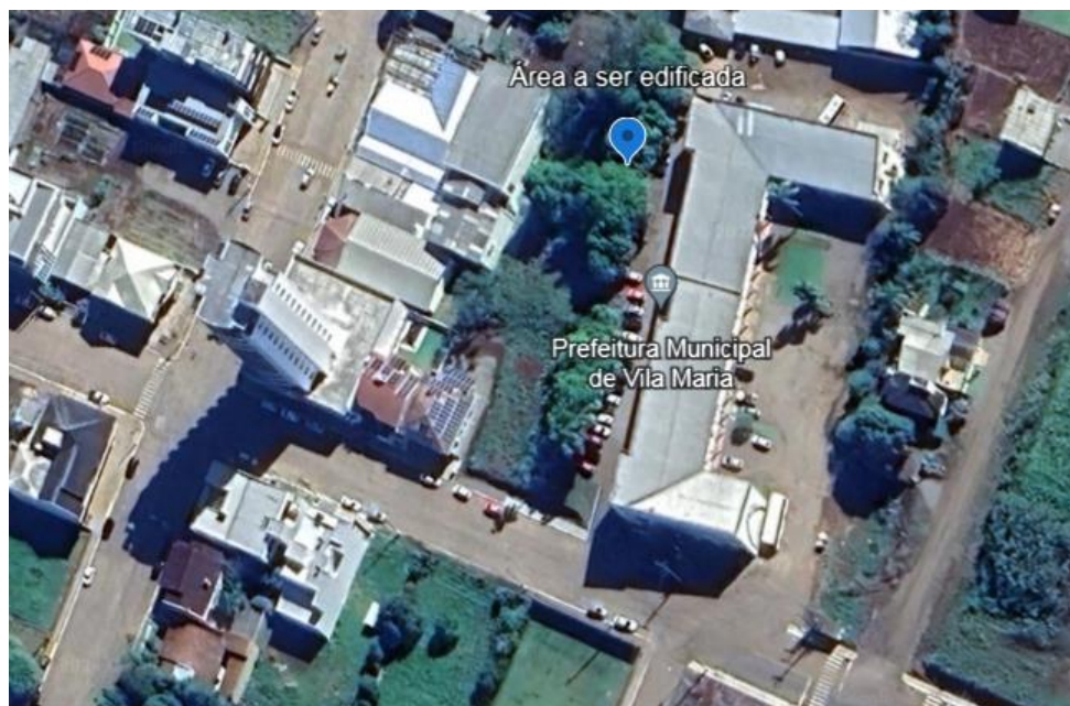
Fig.02: FOTO ÁEREA – FONTE: GOOGLE EARTH MAR/2024.
