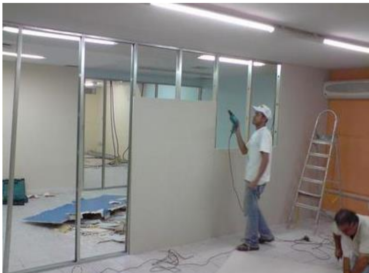
Fig.04: Ilustração das divisórias em drywall.
