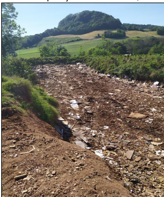
Figura 107 – Deposição dos resíduos, na linha 23.
