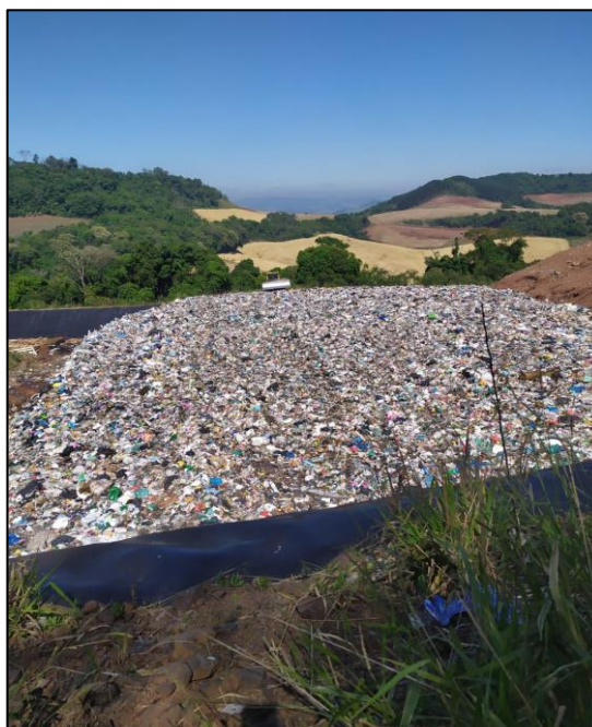
Figura 102 – Trator de esteira ao fundo, realizando a compactação dos resíduos no aterro.
