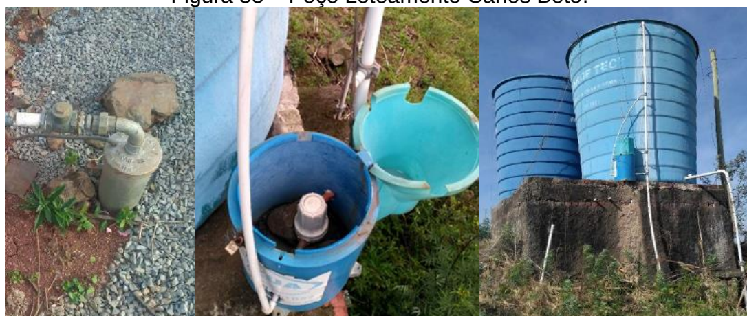
Figura 55 – Poço Loteamento Carlos Beto.
