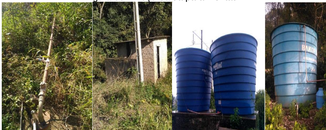
Figura 53 – Poço Saída para Montauri.
