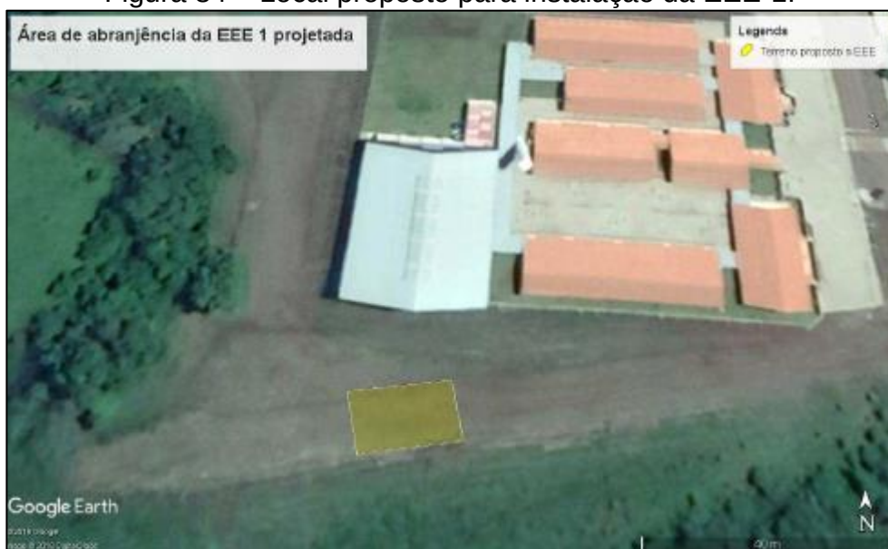
Figura 84 – Local proposto para instalação da EEE-1.
