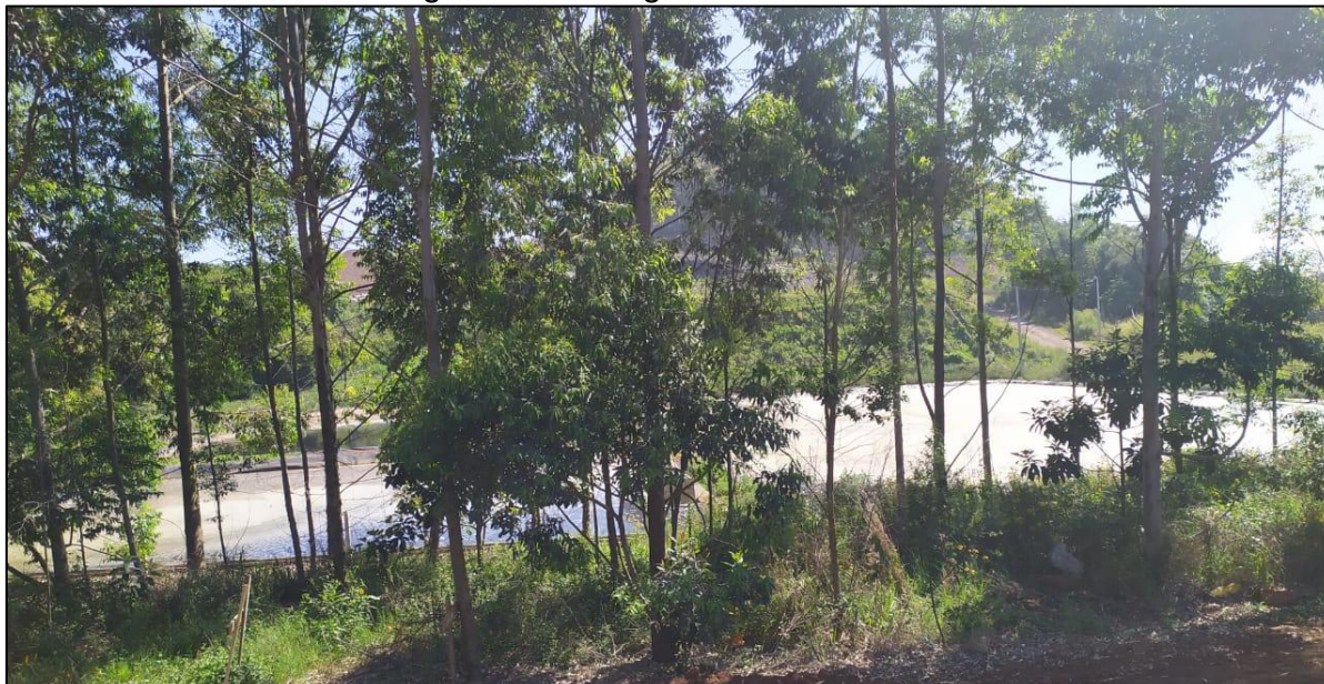
Figura 100 – Lagoas de tratamento.
