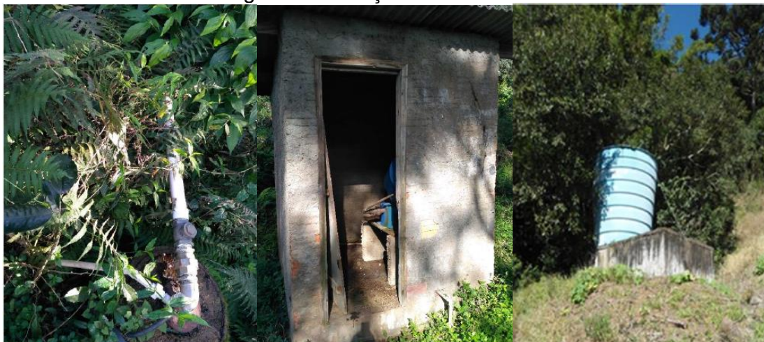
a) Poço de captação; b) Tratamento; c) Reservatório. Fonte: Vila Maria (2020).
