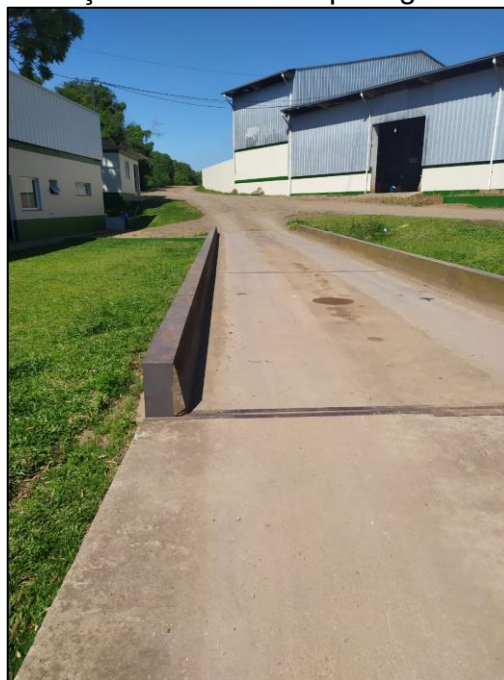
Figura 99 – Balança onde ocorre a pesagem dos caminhões.
