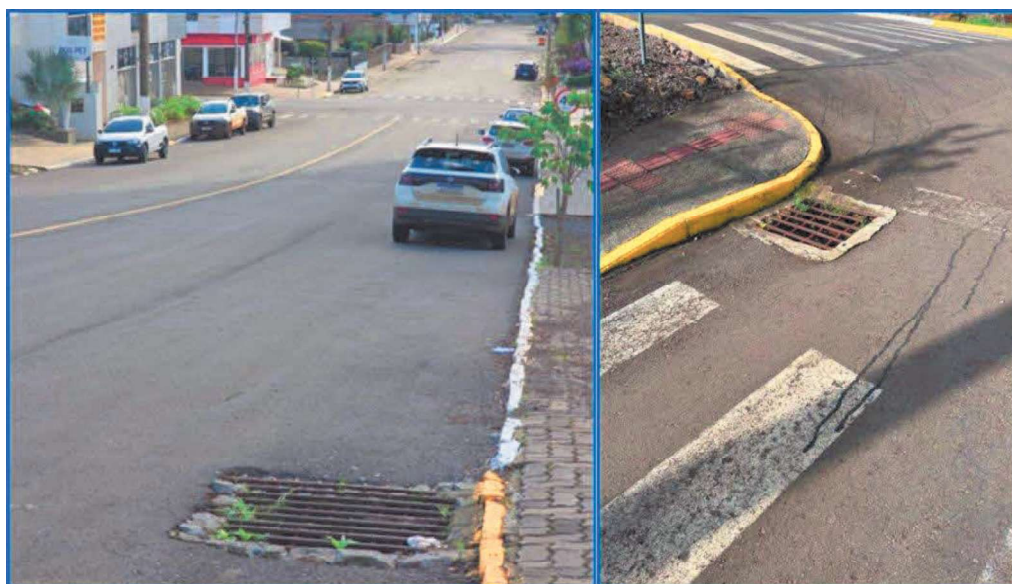
Figura 45 – Estruturas do sistema de drenagem urbano (Fonte: Registro próprio em Vila Maria, 2026)
