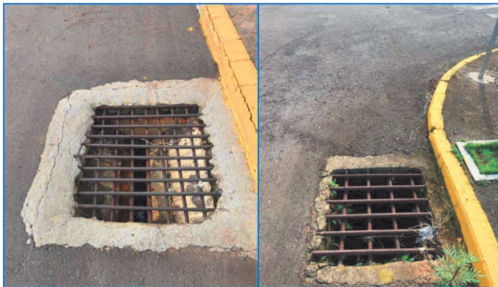
Figura 46 – Estruturas do sistema de drenagem urbano (Fonte: Registro próprio em Vila Maria, 2026)
