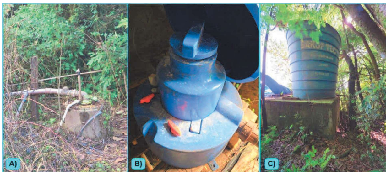
a) Poço de Captação; b) Tratamento; c) Reservatório.
